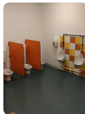
Réfection de la peinture des toilettes de l'école maternelle
