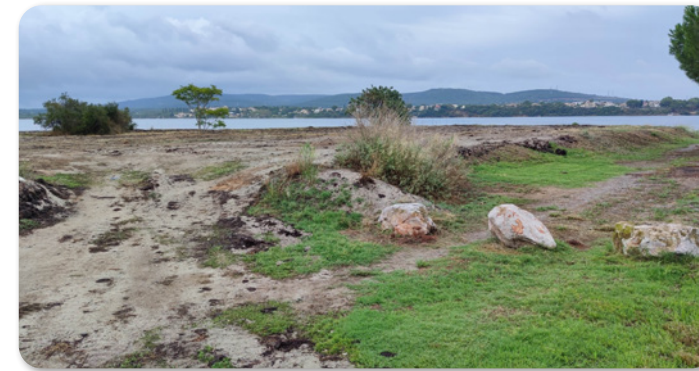
A côté des tennis : préparation d'une parcelle en vue de la plantation d'arbres
