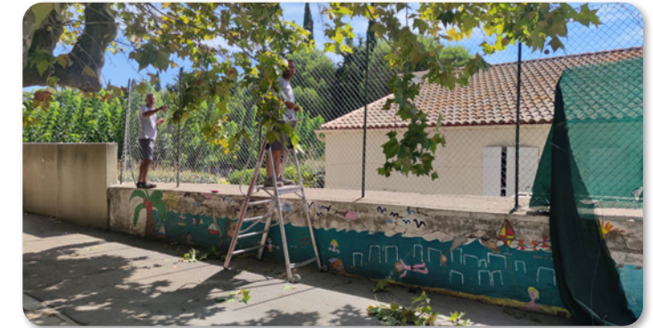
Réparation de la clôture de la cour de l'école
