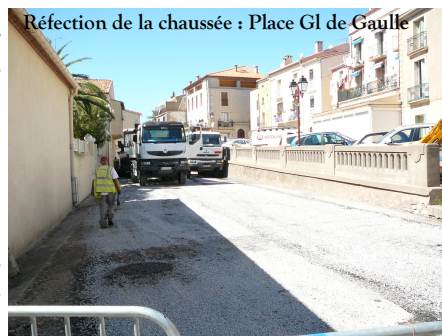
Réfection de la chaussée : Place Gl de Gaulle
