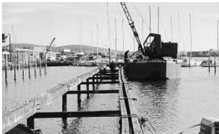
Les travaux de réhabilitation des quais Ouest et Sud sont terminés. Les services techniques de la municipalité en collaboration avec le club nautique de Bouzigues ont réalisé l'installation de 153m de poutres qui sont recouvertes d'un plancher de 110 m2 flambant neuf. Il vient à point nommé pour ouvrir la saison nautique.
